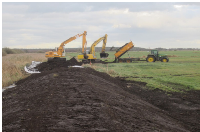
Baumaßnahme 2013: Herstellung der Sollhöhe an der Verwallung Brameler Randgraben
