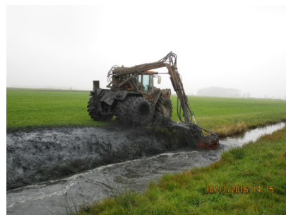
Gebietsräumung mit der Lotmaschine
