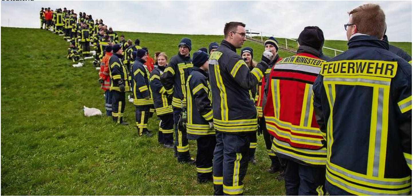
Dicht nebeneinander standen die Einsatzkräfte in Cappel-Neufeld. Ihre Aufgabe: Mehr als zehn Kilogramm schwere Sandsäcke bis zur Deichkrone durchzureichen. Leuschner
