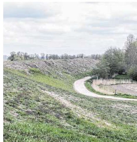
Der Deich zwischen Nedderwarder Weg und Klintweg in Neuenkirchen ist auf acht Meter erhöht worden. FOTO: CHRISTIAN KOSAK
