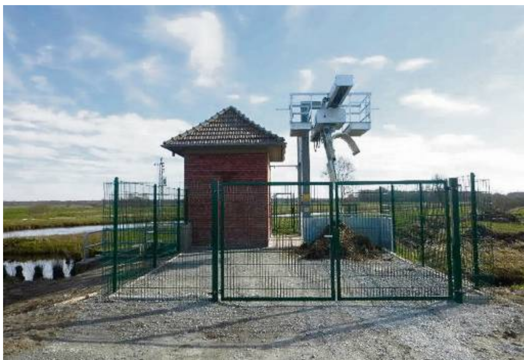
Die sogenannten Sieloder Schöpfwerksgebäude mit ihren zugehörigen Anlagen.
