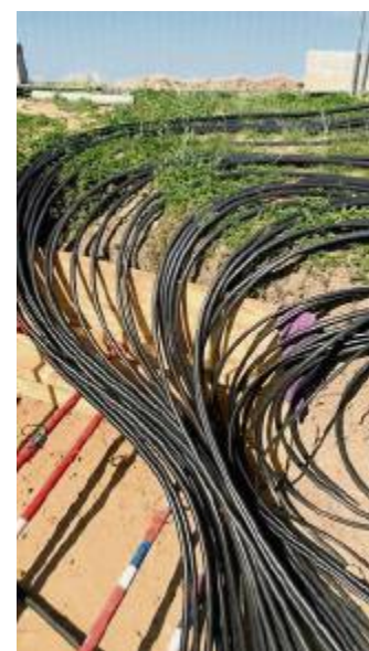
Viel Kabel für die Elektrifizierung eines Schöpfwerkes.
