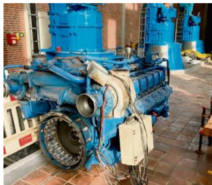
Im Siel- und Schöpfwerk Lune wurden die Dieselaggregate rückgebaut und der Pumpenbetrieb elektrifiziert.
