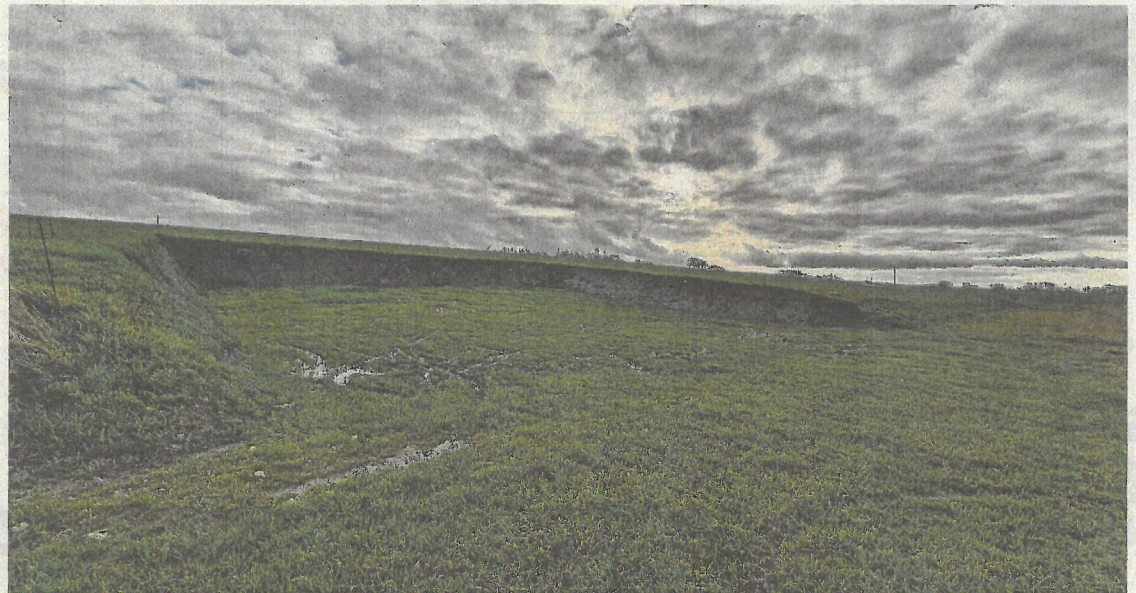
Was aussieht wie eine Lücke im Hauptdeich von Spieka-Neufeld, ist keine: Über dem eigentlichen Deich befindet sich eine mit Gras bewachsene Kleibodenschicht. Diese wird in Kürze zur Deicherhöhung gebraucht. Foto: Leuschner
