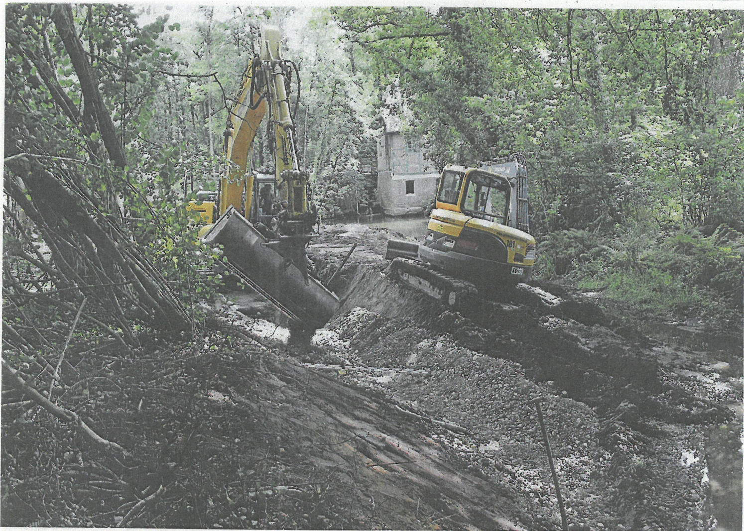
Mit schwerem Gerät wird die Umleitung der Drepte gebaggert. Der neue Verlauf soll den Fischzug in einem ortstypischen Verlauf mit Kiesbett erlauben und einen Beitrag zur Renaturierung leisten.
