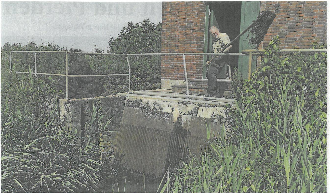
**Knochenarbeit:** Schöpfwerkswärter Hans-Georg Harrie muss jede Menge Pflanzenreste per Hand aus dem Wasser holen, weil sonst der Zufluss zu den Pumpen im Schöpfwerk verstopft wird. Diese Arbeit soll nach der Modernisierung automatisch erledigt werden. Fotos: Fixy
