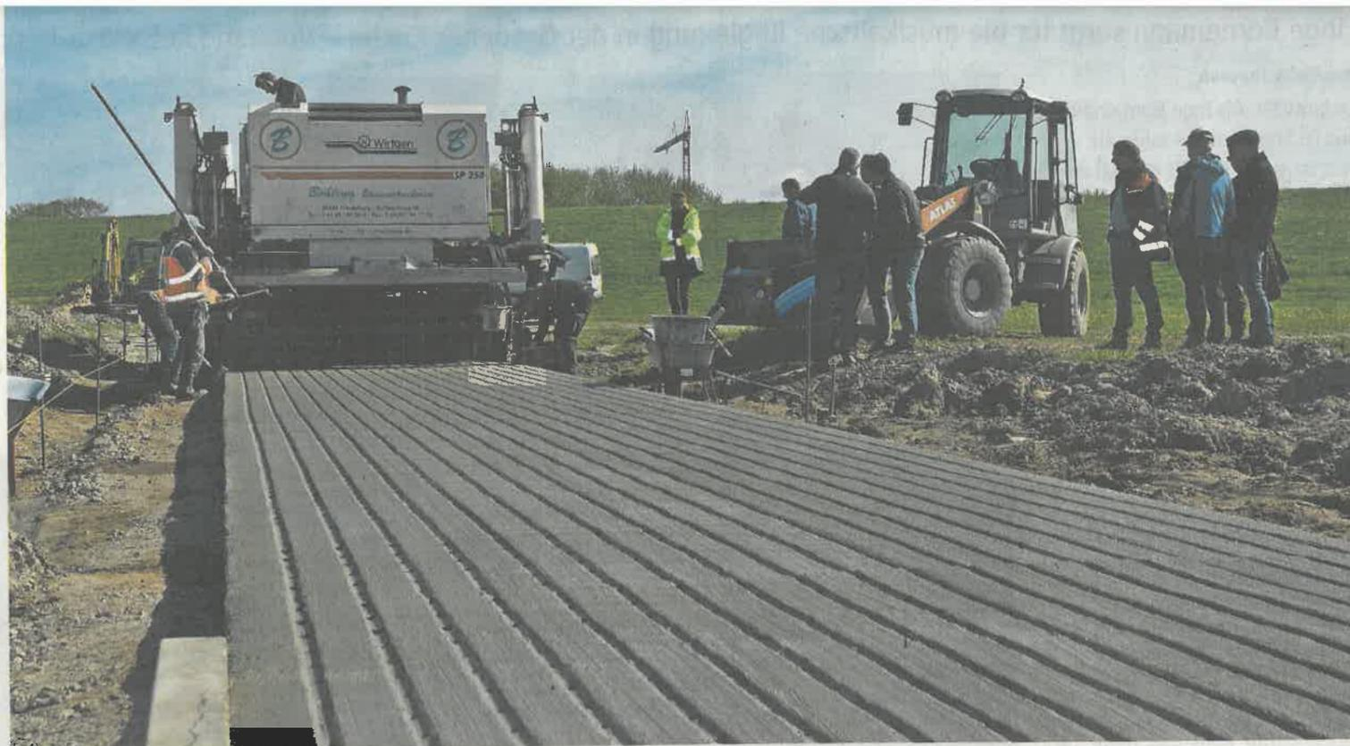
Ein neuer Betonweg wird derzeit am Wremer Tief gegossen. Er soll aber nicht von Radfahrern genutzt werden – daher die Rillen.
